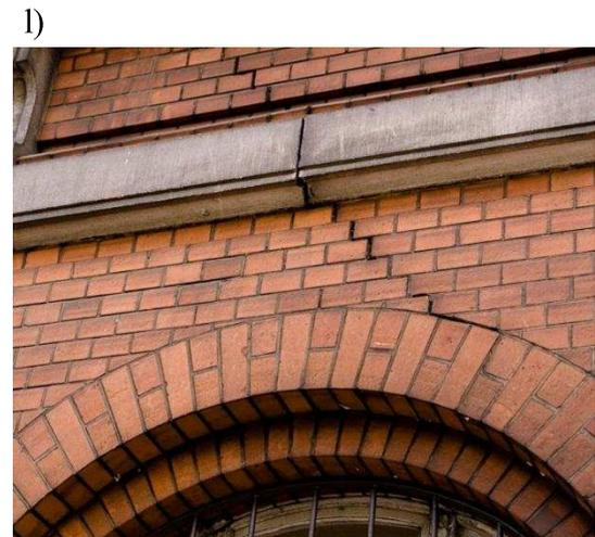
Rys. 3.5. Przykłady uszkodzeń nadproży łukowych
