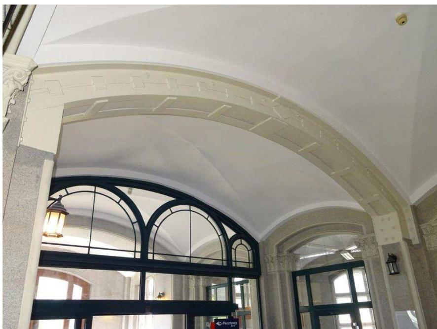
Rys. 7.4. Przykład wdrożenia sposobu naprawy nadproży łukowych poprzez podparcie konstrukcją stalową na poczcie głównej w Szczecinie przy ul. Dworcowej (rys. 7.3 a)
